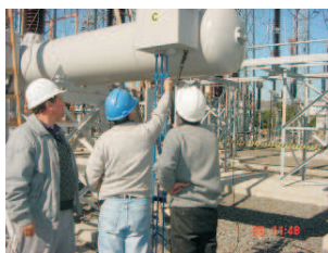
Ajustando disjuntor para atender aos requisitos de tempo
